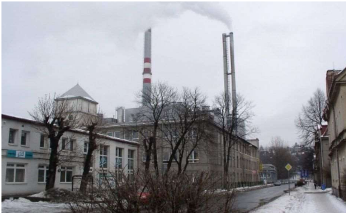
FOTOGRAFIE: Spalovna odpadů v Liberci.
